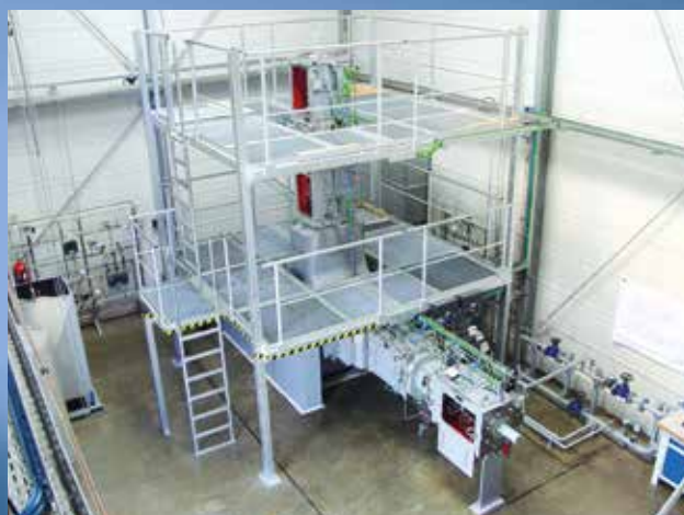
Test-Kompressor im Hause STASSKOL
